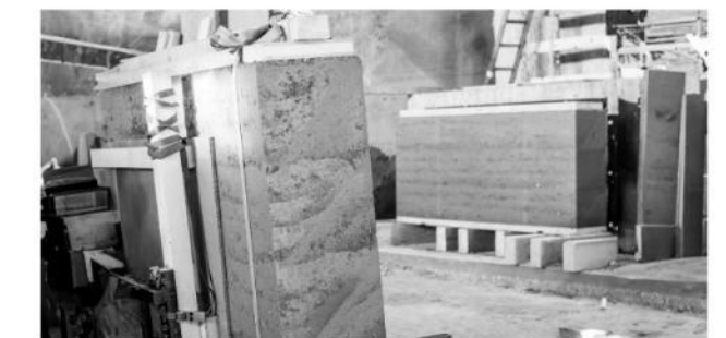
Teilprojekt 4: Produktion und Trocknung Stampflehmfertigteile >
